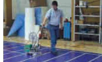
Армирование тентового покрытия с помощью армирующей ленты аппаратом ТЭЙПМАТ.
