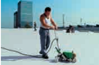
Сварочный автомат ВАРИМАТ при сварке полимерного кровельного покрытия.
