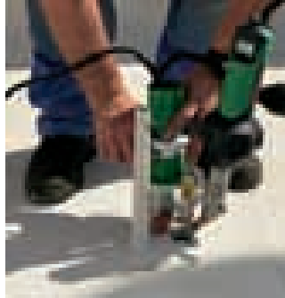
TRIAC DRIVE варит как на горизонтальных поверхностях,...
