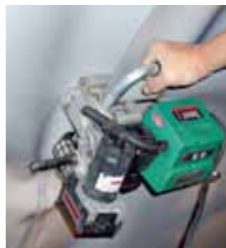
TWINNY T с практичной поперечной рукояткой во время сварки над головой в туннеле.
