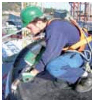
Мощный WELDPLAST S4 в работе.
