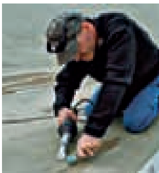
Сварка стыков при помощи TRIAC PID и щелевой насадки.
