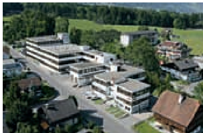
Производственные корпуса Leister Process Technologies, Кегисвиль, Швейцария
