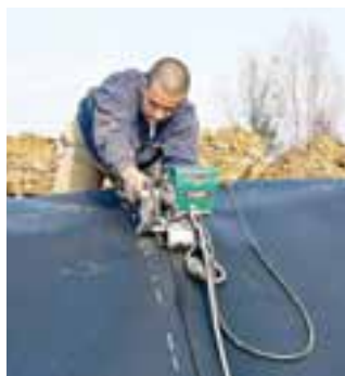
... на обустройстве полигона.
