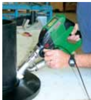
Сварка трубы аппаратом WELDPLAST S2
