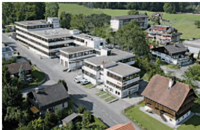
Leister Technologies AG, производственное здание, Кегисвиль, Швейцария
