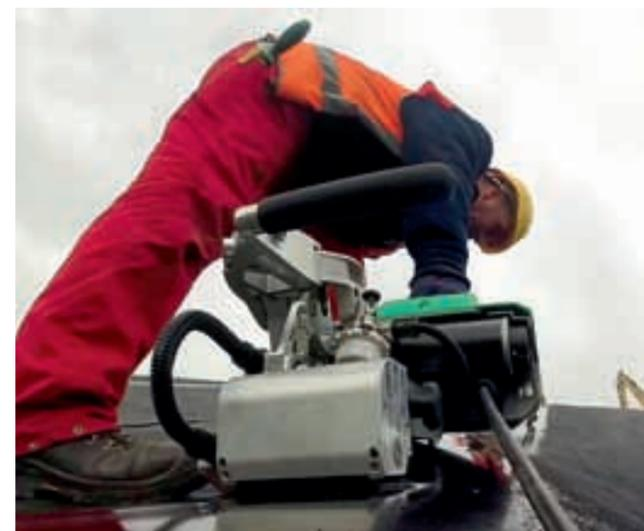
Сварка ПЭНД мембраны аппаратом GEOSTAR.
