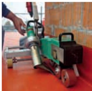
VARIMAT V2 при сварке кровельного покрытия в труднодоступных местах.
