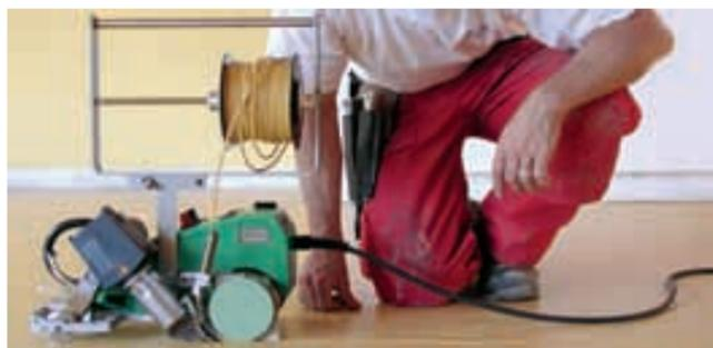
Сварка напольных покрытий сварочным автоматом Unifloor E.
